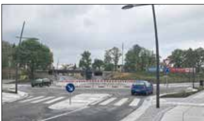
Kreisverkehr „an der großen Unterführung“ fertiggestellt
